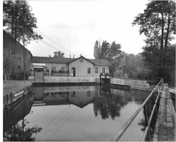
*Kraftwerksanlage Ettmannsdorf, von links altes Mühlengebäude mit Dieselmotorkraftwerk, querstehendes Wasserkraftwerk, mit Einlauf und Rechenreinigungsmaschine und rechts der Leerschuß.*
