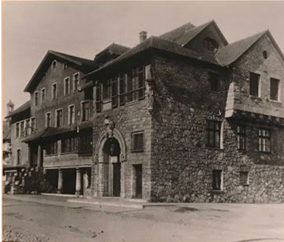
BBI Verwaltungsgebäude in Wackersdorf ab 1933 (Anton Eiselbrecher)
