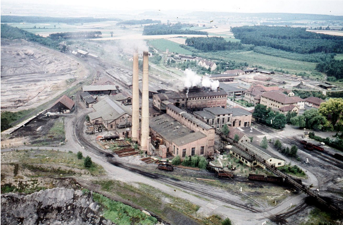
Von Osten gesehen: 1 Maschinenhaus mit Turbinen und Generatoren, 2 Elektro-Werkstatt, 3 Schrägbrücke für Kettenbahn zum Wipperboden, 4 Schlackeverladung (Karl Jobst)
