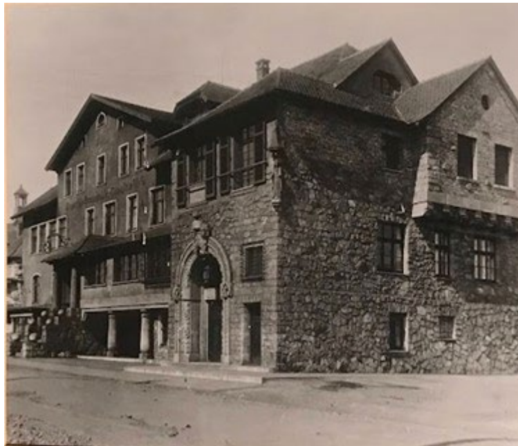
Das fertiggestellte Konsumvereinshaus von 1910 und Verwaltungsgebäude im Jahre 1933, unten links der Werkskonsum, rechts das Eingangstor zur Verwaltung (Anton Eiselbrecher)
