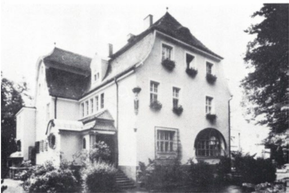
Direktoren-Villa von Oskar Kösters auf der Rothlindenhöhe in Schwandorf (Stadtarchiv Schwandorf)
