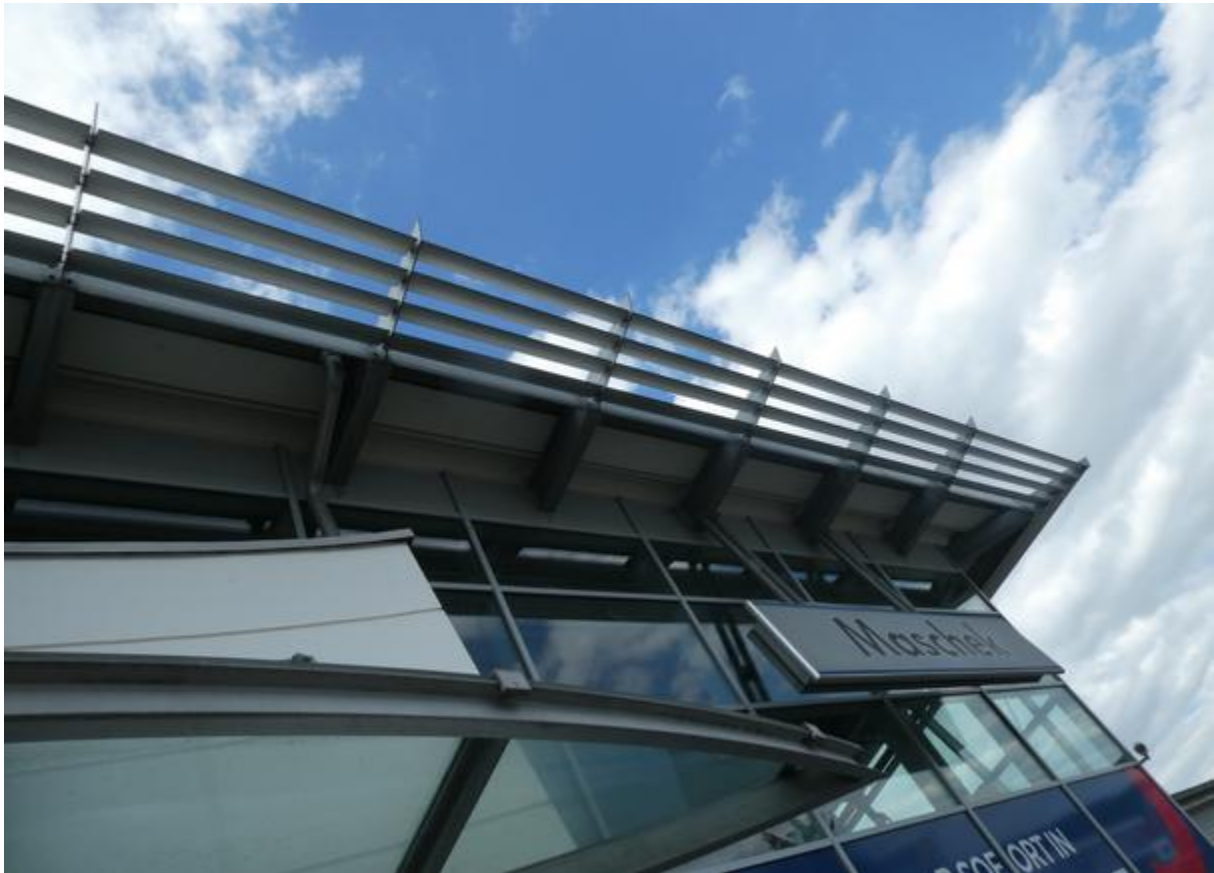
Abbildung 49: Östliche Gebäudefront (Gebäudeteil 6), Showroom, rechte Seite
