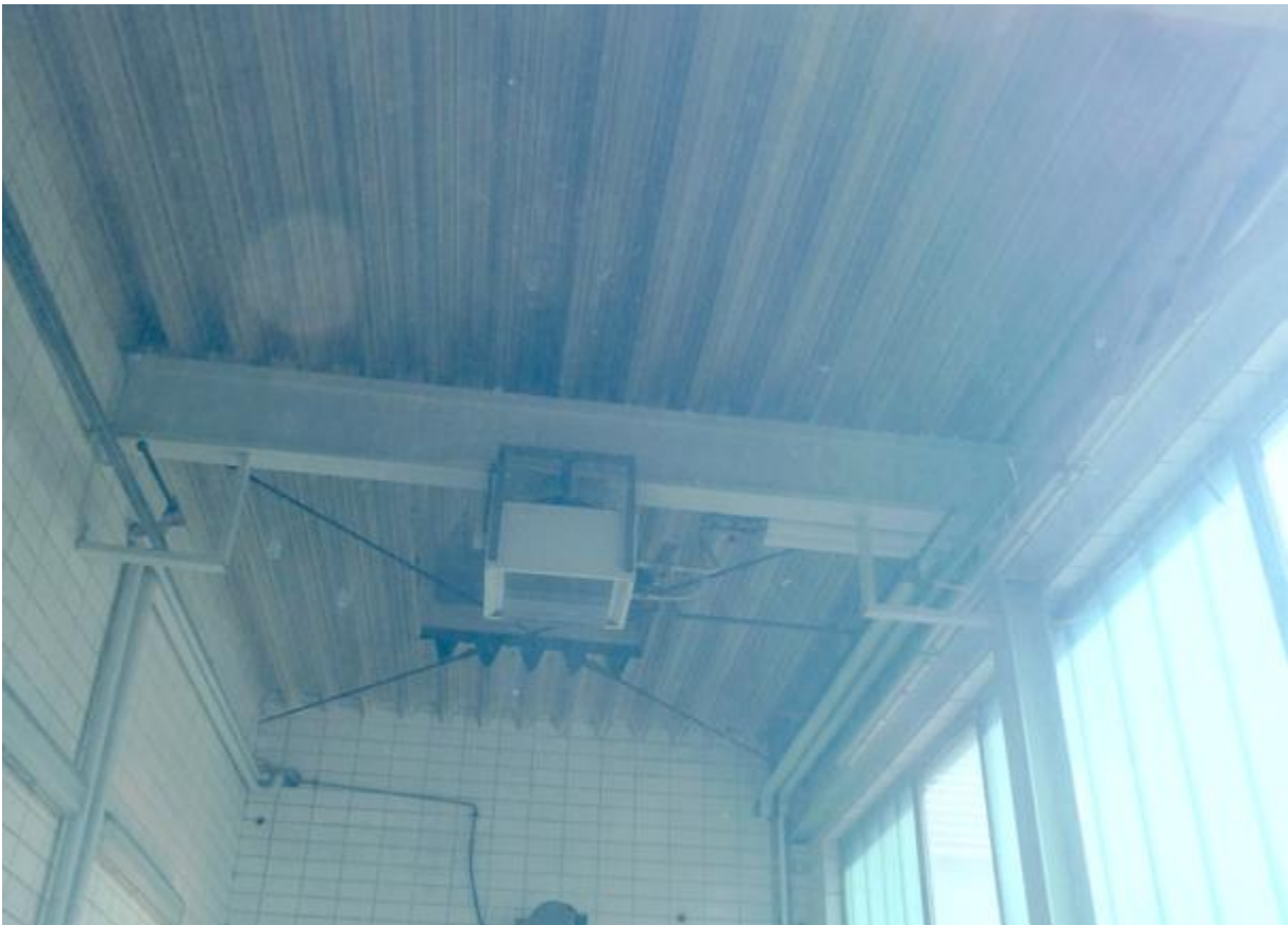
Abbildung 48: Waschstraße, Dach und Wände (Gebäudeteil 7)
