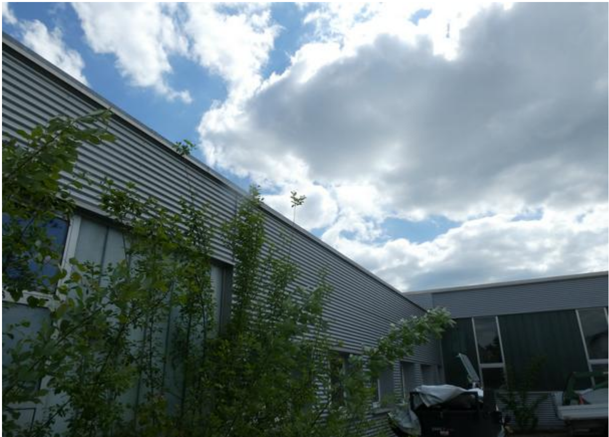
Abbildung 56: Westliche Gebäudefront, links (Gebäudeteile 4, 6 und 7)
