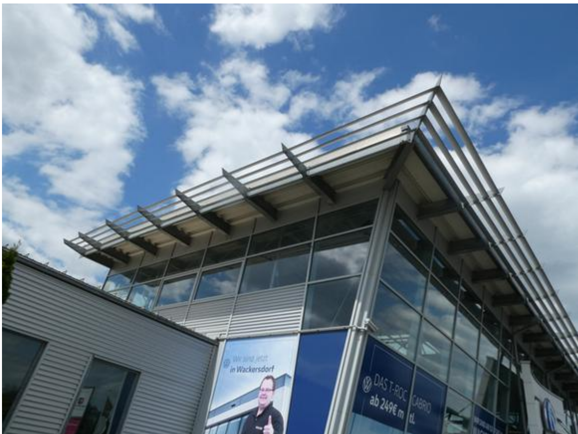
Abbildung 50: Östliche Gebäudefront (Gebäudeteil 6), Showroom, linke Seite
