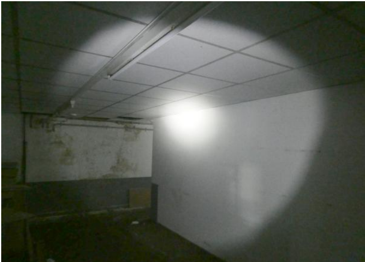
Abbildung 42: Dunkler Lagerraum (Gebäudeteil 5), rechts. Foto nachträglich aufgehellert.
