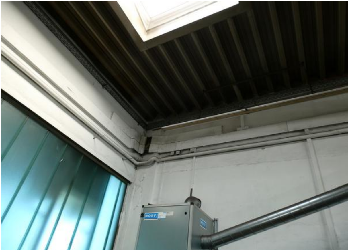
Abbildung 35: Dach-Wand-Übergang, Werkstatt hinten (Gebäudeteil 3a)
