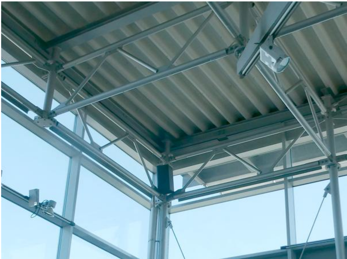
Abbildung 46: Detailansicht Dach-Wand-Übergang im Verkaufsraum (Gebäudeteil 6)
