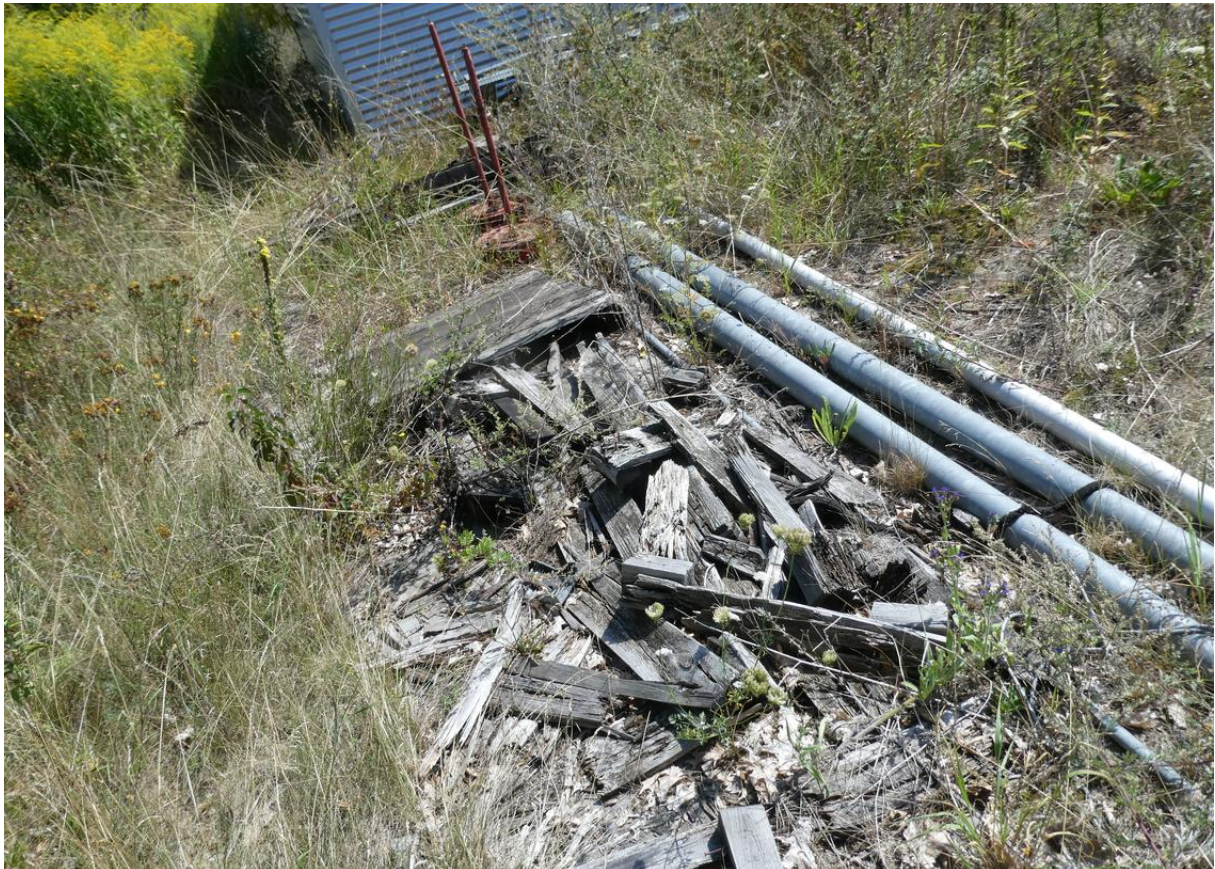
Abbildung 28: Östlicher Geltungsbereich; Holz- und Materialablagerungen
