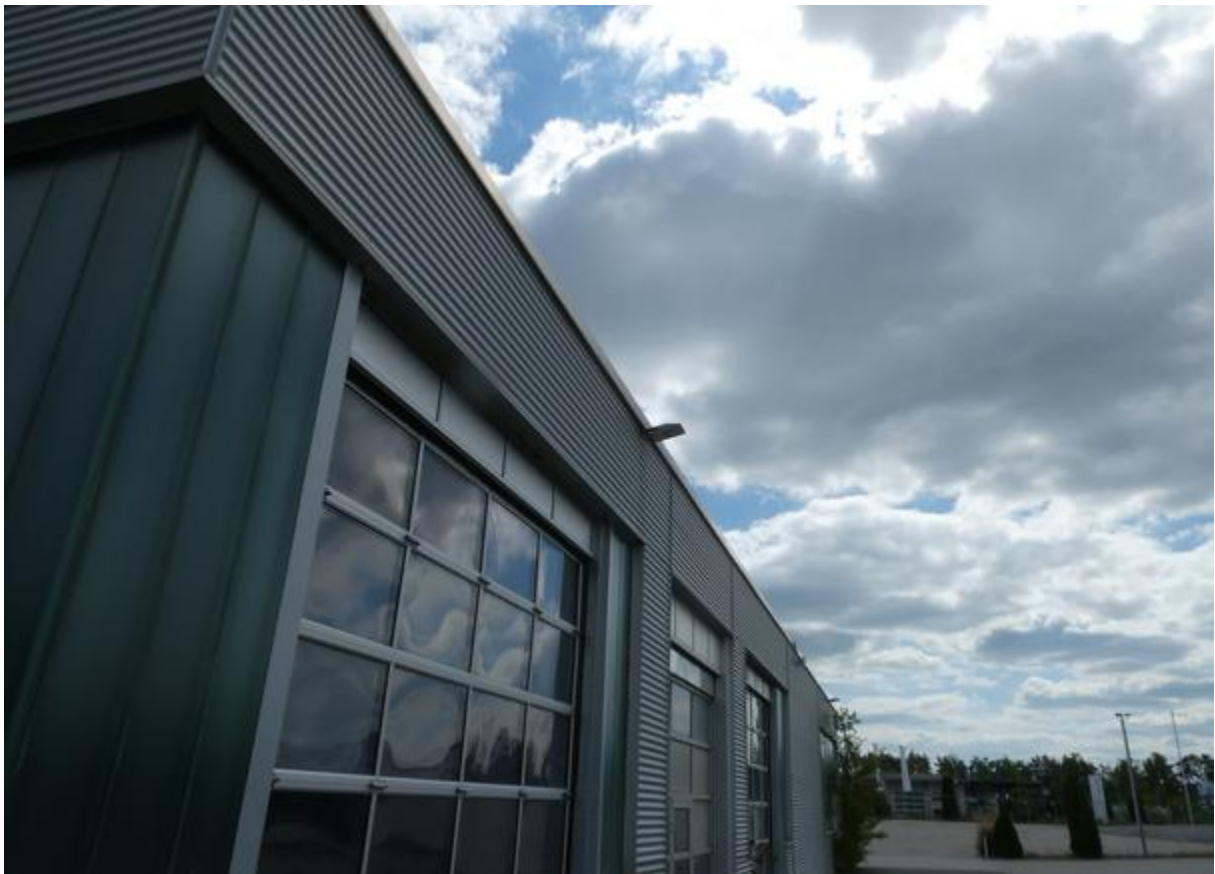
Abbildung 55: Westliche Gebäudefront, rechts (Gebäudeteil 7)
