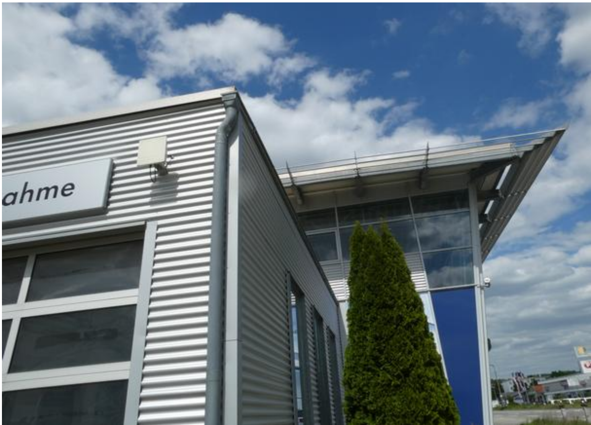
Abbildung 51: Östliche Gebäudefront (Gebäudeteile 1, 2 und 3)
