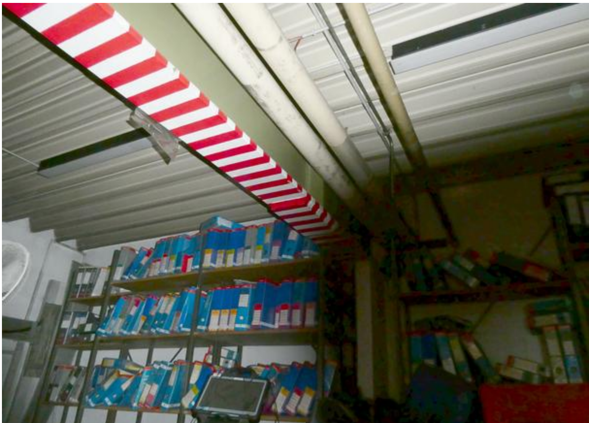
Abbildung 36: Dunkler Lagerraum (Gebäudeteil 3b, oben)
