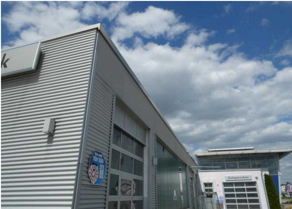
Abbildung 52: Östliche Gebäudefront, rechts (Gebäudeteile 1, 2 und 3)
