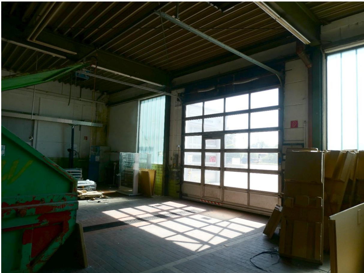
Abbildung 32: Werkstatt vorderer Bereich (Gebäudeteil 3a, unten)
