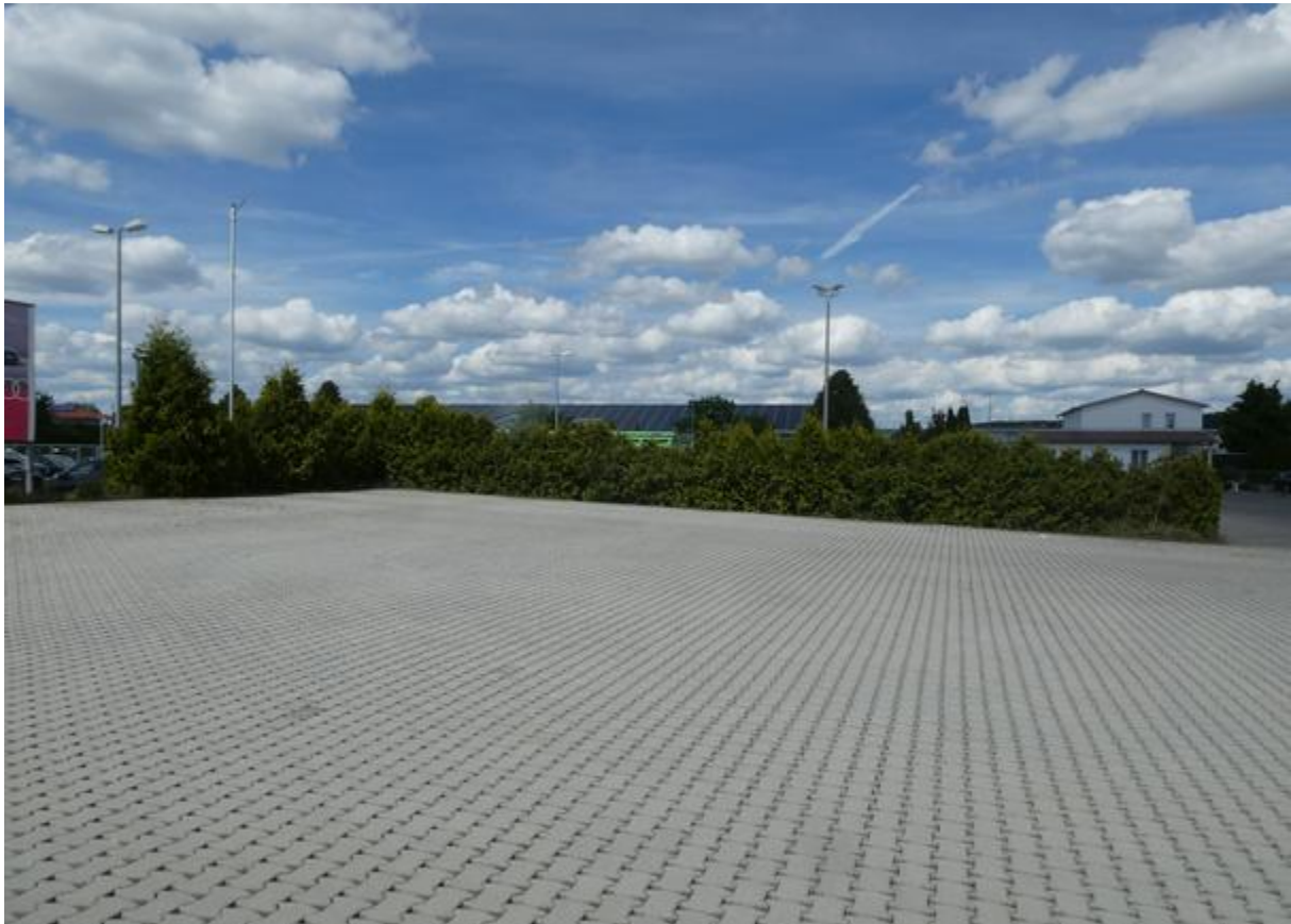
Abbildung 24: Östlicher Geltungsbereich, Blickrichtung Nord
