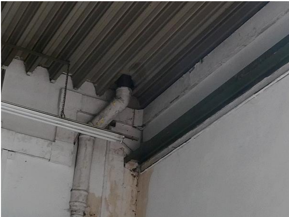
Abbildung 33: Decken-Wand-Übergang (Gebäudeteil 3a, unten)
