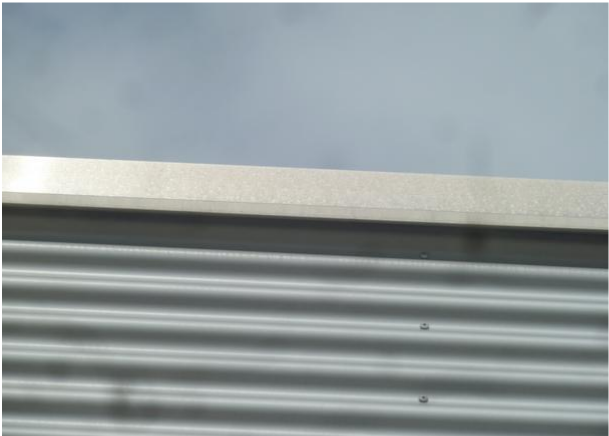
Abbildung 58: Detailansicht Wand-Dach-Übergang. Beispielhaft für alle Gebäudefronten
