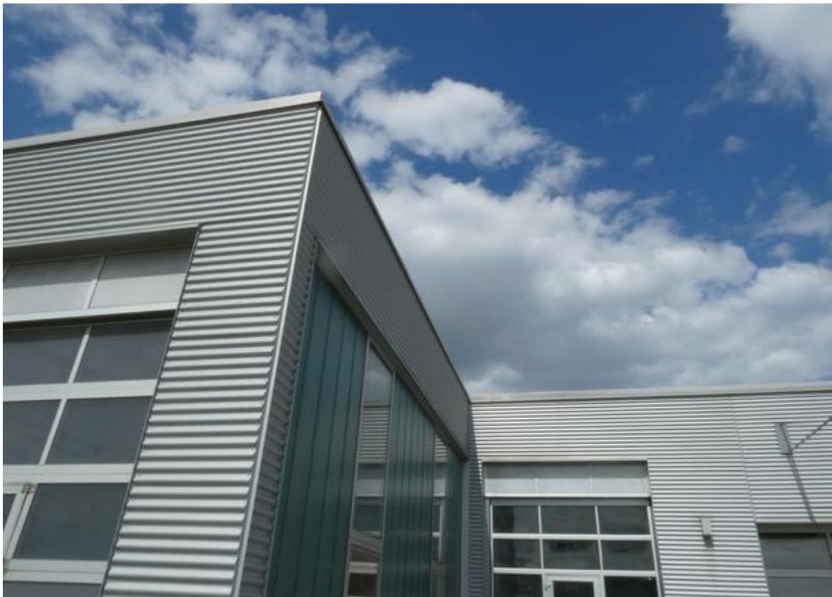
Abbildung 54: Südliche Gebäudefront, linke Seite (Gebäudeteile 3 und 7)
