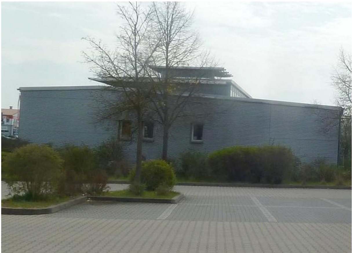
Abbildung 57: Nördliche Gebäudefront (Gebäudeteil 6)
