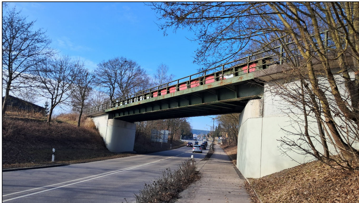
Abbildung 6 Brücke aus stählernem Überbau über die Wackersdorfer Straße (f)
